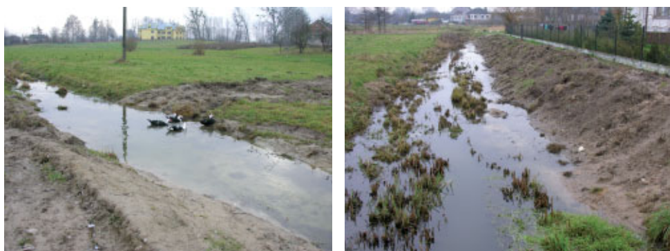
Fot. 7, 8. Przykład antropopresji dotykającej ciek, będący stanowiskiem łątki ozdobnej – realizacja wiejskiego wodociągu przez ciek (po lewej) i w sąsiedztwie ciek (© W. Michalczyk).
