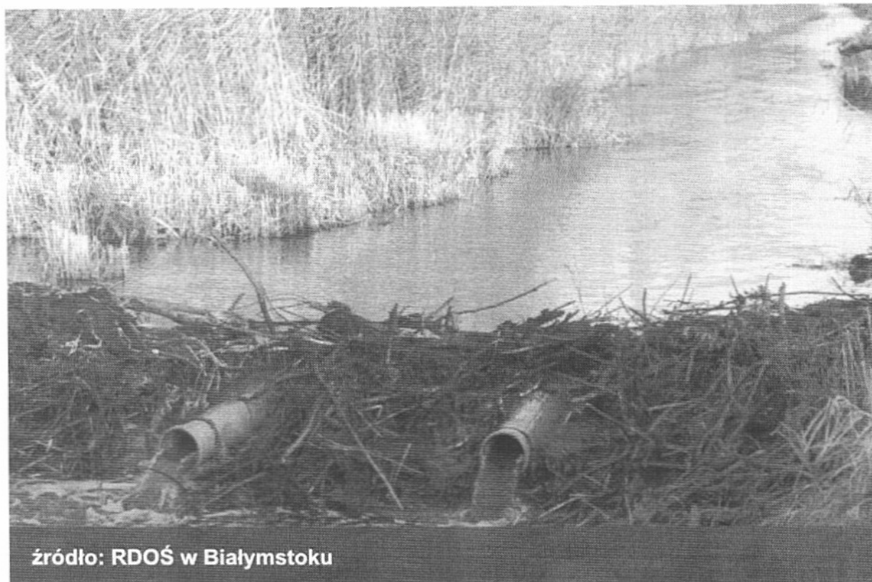
Rys. 2. Sposób montażu rur przelewowych
