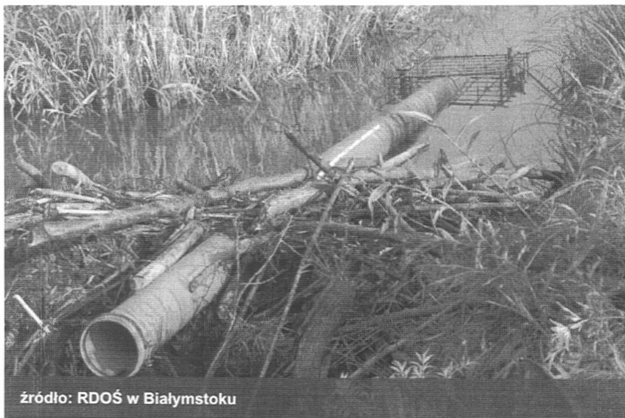
Rys. 2. Sposób montażu rur przelewowych
