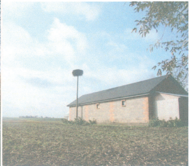
4. Gniazdo przeznaczone do rewitalizacji w miejscowości Stefankowice
